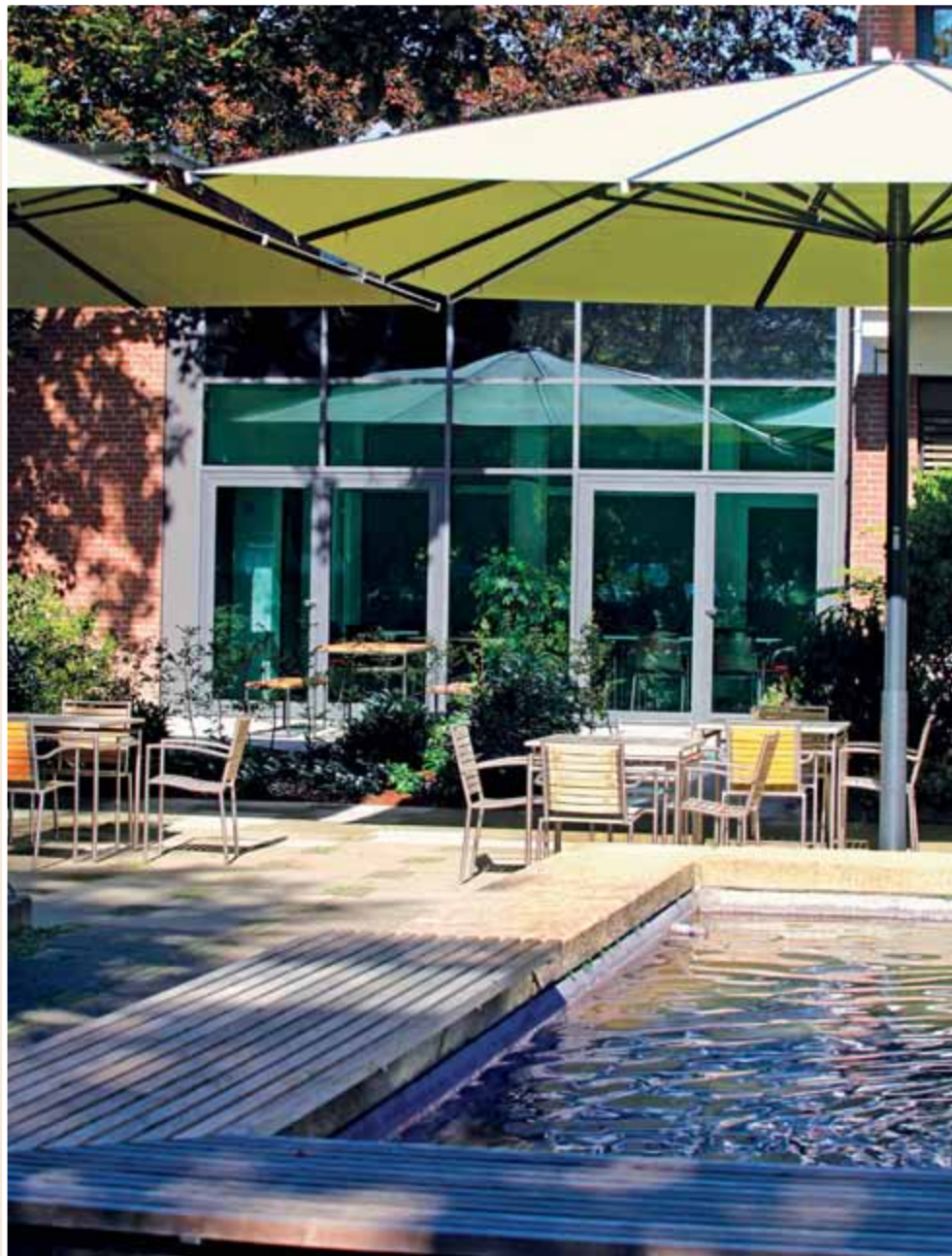
2015 wurde im SBZ ein Wintergarten angebaut.
