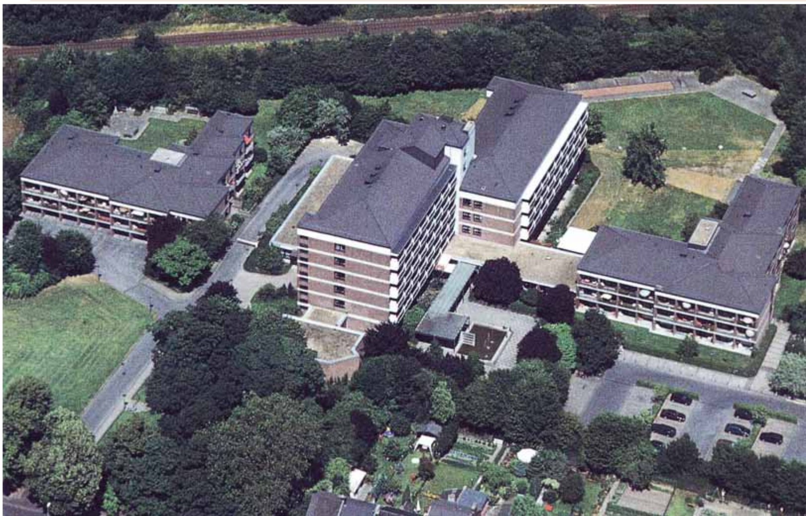
Die Luftaufnahme zeigt das Kreisaltenheim um 1990.
