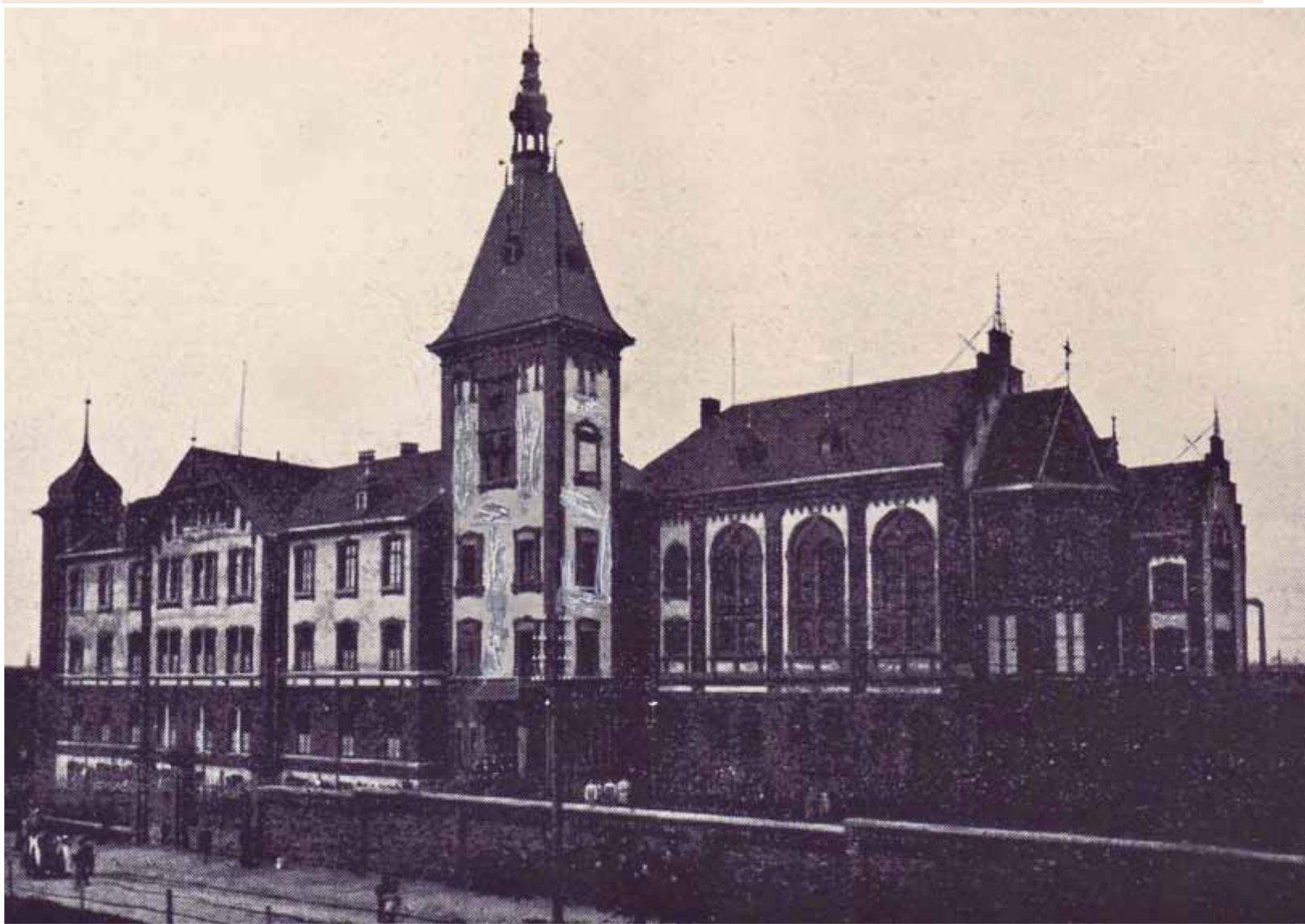
Gesamtansicht des Kreispflegehauses um 1950.
