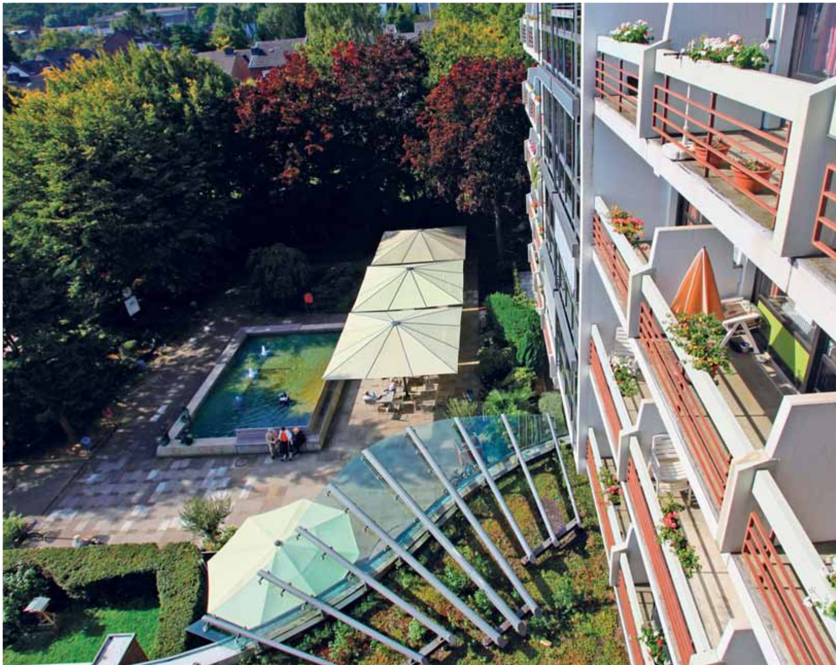
Ein Blick aus luftiger Höhe auf die neue Sonnen-Terrasse 2010.
