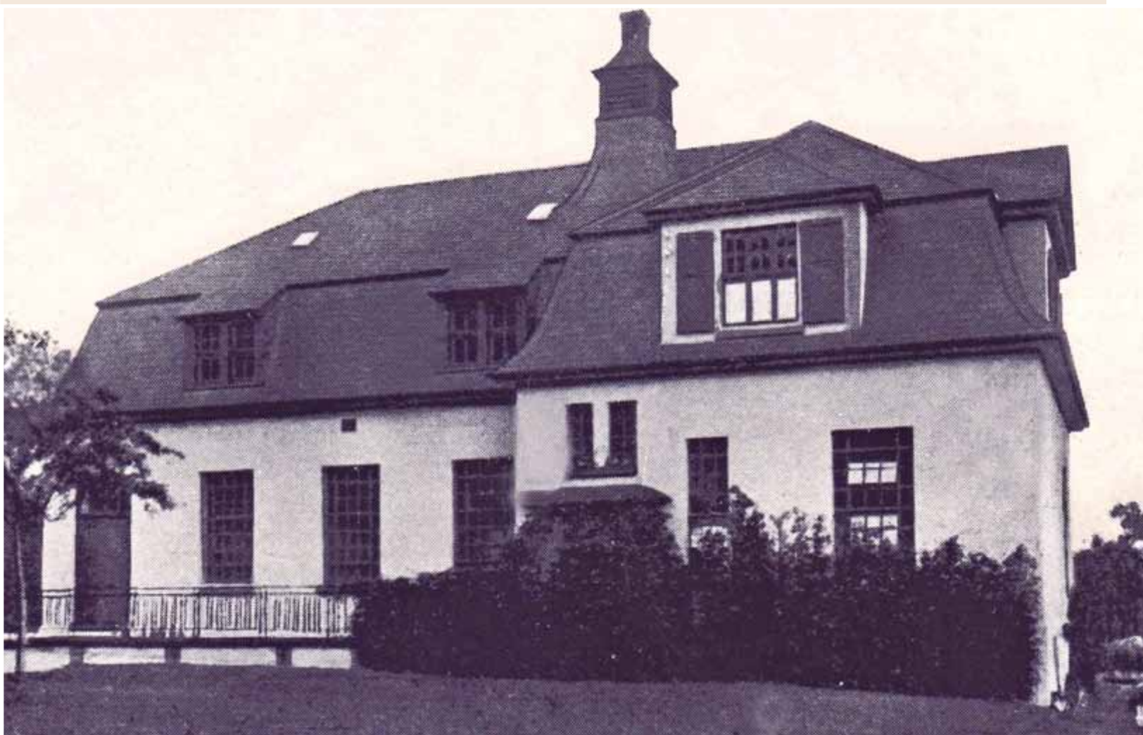
Die neue Waschküche des Kreispflegehauses um 1910.
