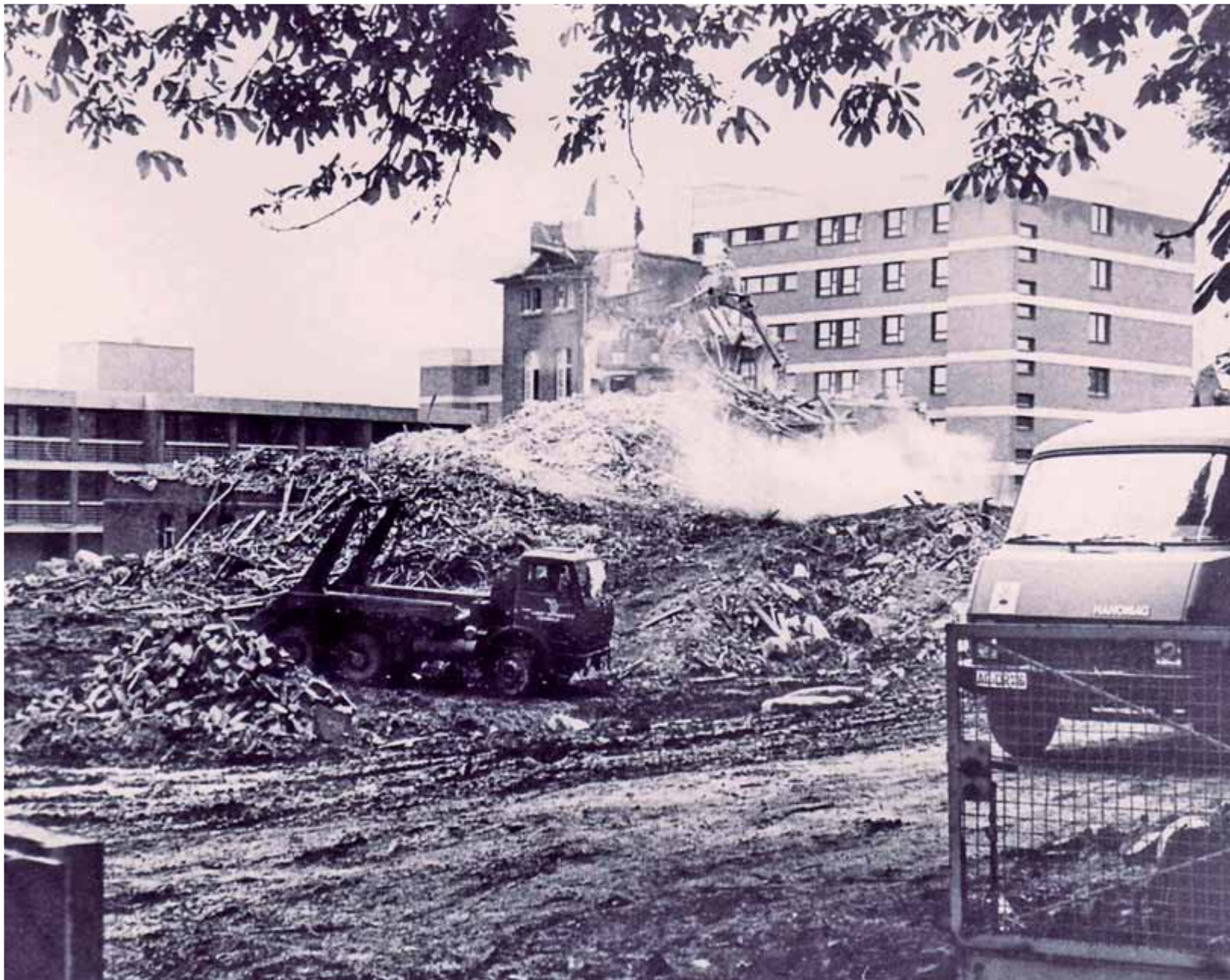
Abbrucharbeiten am Kreisaltenheim nach der Sprengung 1978.
