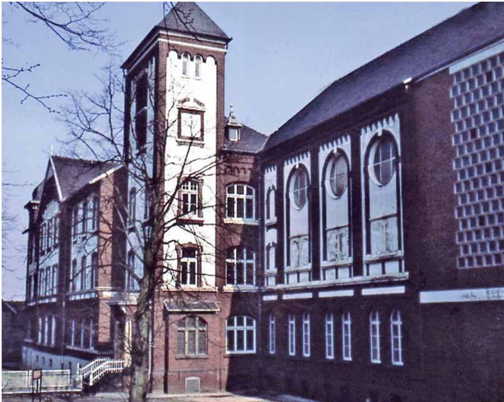
Das Kreisaltenheim im April 1978 kurz vor der Sprengung.
